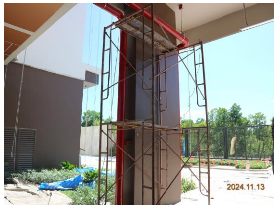
รูปที่ 3.1-48 นั่งร้านที่ได้มาตรฐาน สำหรับการทำงานบนที่สูงเกิน 2 เมตรขึ้นไป
