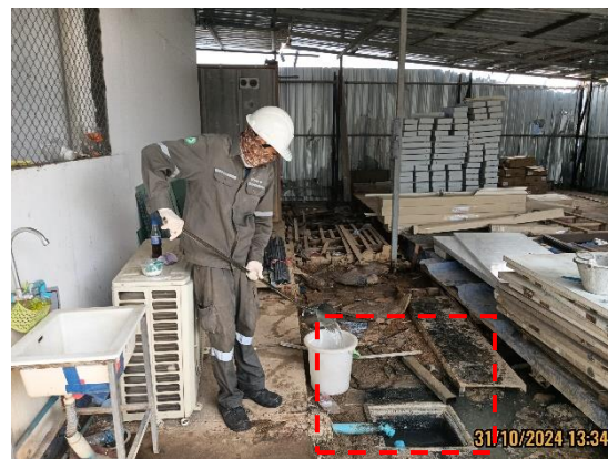
รูปที่ 3.1-29 ปอดักตะกอนภายในพื้นที่ก่อสร้าง
