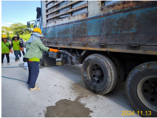
รูปที่ 3.1-10 จุดล้างล้อรถบรรทุกก่อนออกนอกพื้นที่ โครงการ
