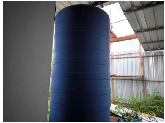
รูปที่ 3.1-28 ถังสำรองน้ำใช้ ไม่น้อยกว่า 18 ลูกบาศก์เมตร
